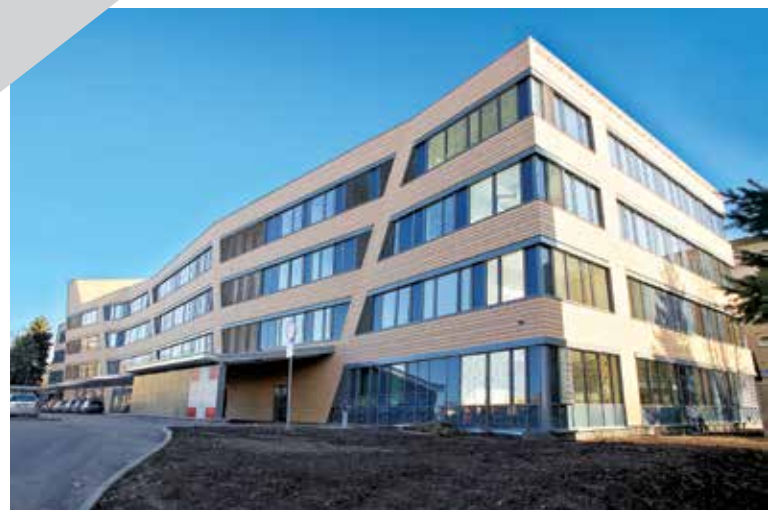
NEMOCNICE KLADNO, STAVEBNÍ ČÁST CENTRA AKUTNÍ MEDICÍNY Investiční náklady bez DPH 1,2 miliardy Kč Výstavba objektu a jeho napojení na stávající monoblok nemocnice.
